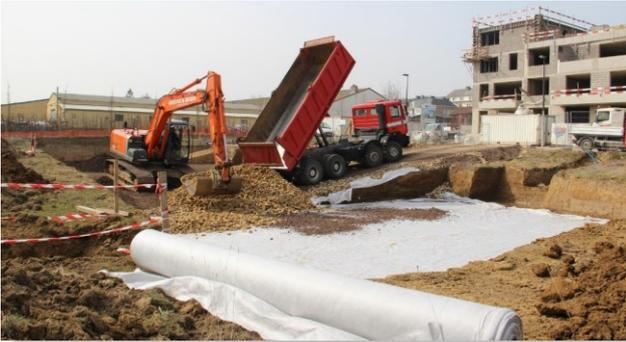
Déblaiement des terres arables sur toute la surface du bâtiment à construire. Terrassement en pleine masse jusqu'au niveau inférieur, comprenant le terrassement pour le radier et les rigoles de fondations, ainsi que le terrassement des canalisations, conformément aux indications des plans de l'Architecte et de l'Ingénieur-conseil.
