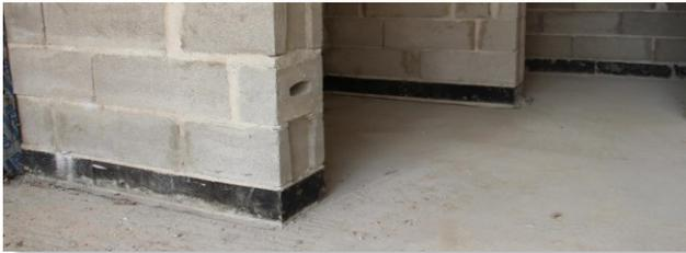
Afin d'éviter les ponts thermiques et selon les besoins et les possibilités techniques, les maçonneries situées dans l'enveloppe thermique reposent sur un rupteur thermique du type bloc de béton cellulaire ou SCHÖCK NOVOMUR ou FOAMGLAS PERINSUL. Le type et l'épaisseur de ce rupteur sont définis en fonction du calcul énergétique, ainsi que conformément aux indications et aux calculs de l'Ingénieur-conseil.
